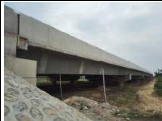
北金堤滞洪区特大桥
