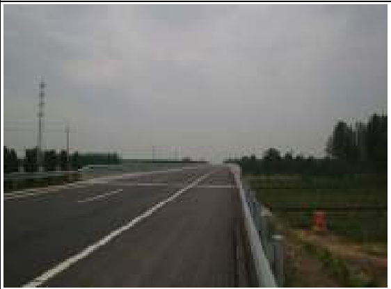
北金堤滞洪区特大桥
