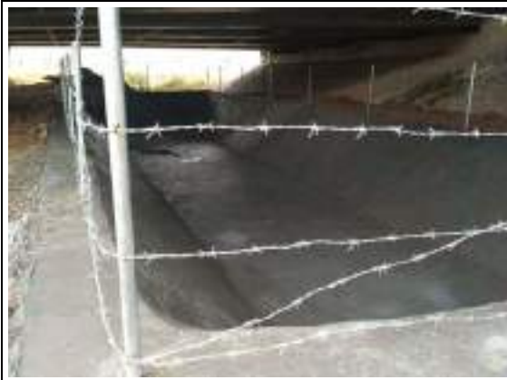
孟楼河大桥事故池
