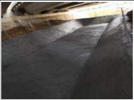
孟楼河大桥事故池
