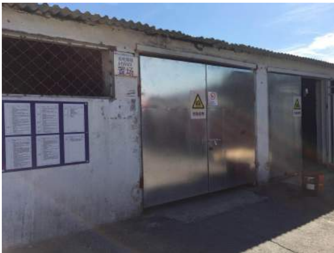
危险废物暂存间
