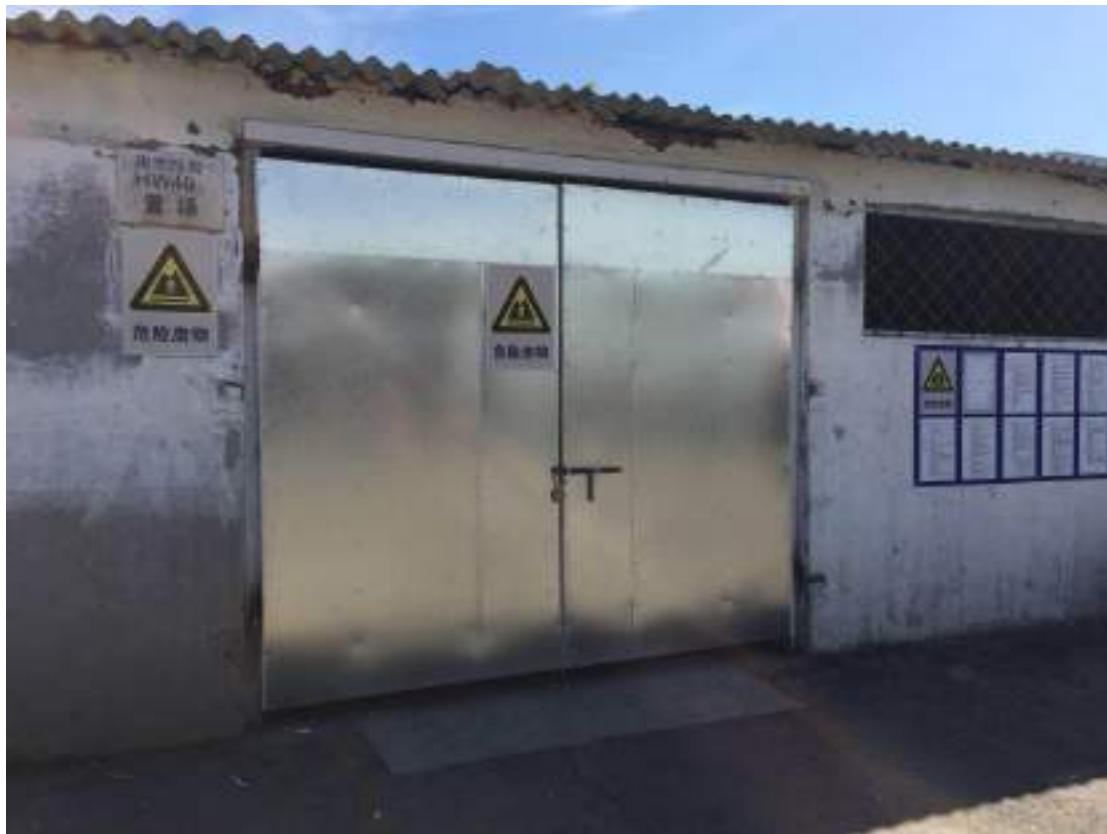
危险废物暂存间
