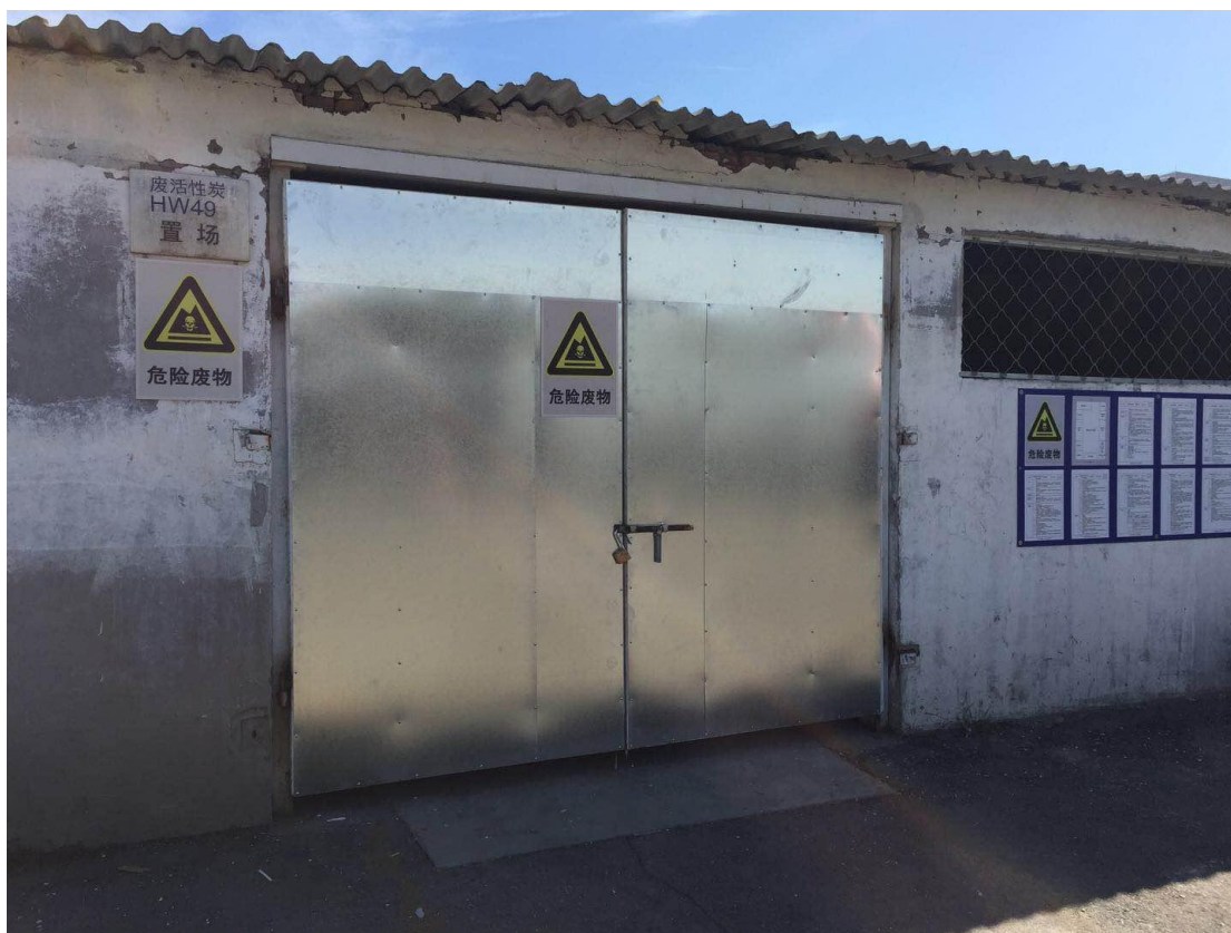
危险废物暂存间
