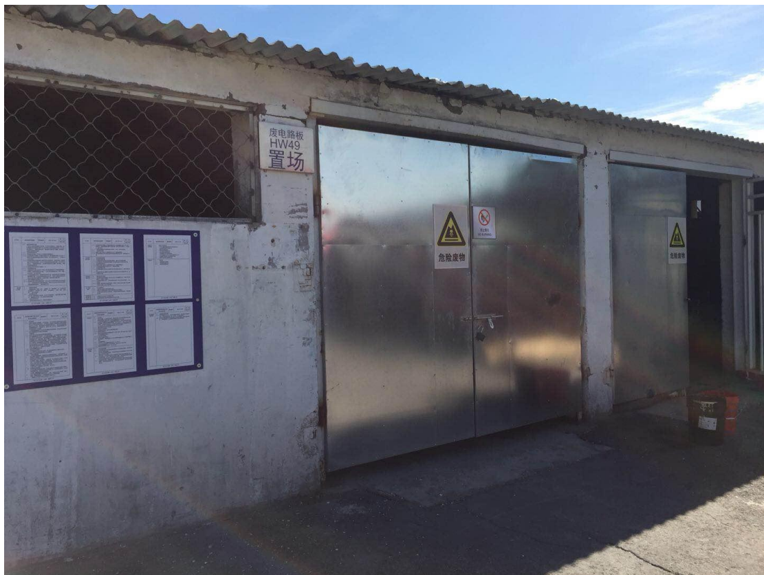
危险废物暂存间
