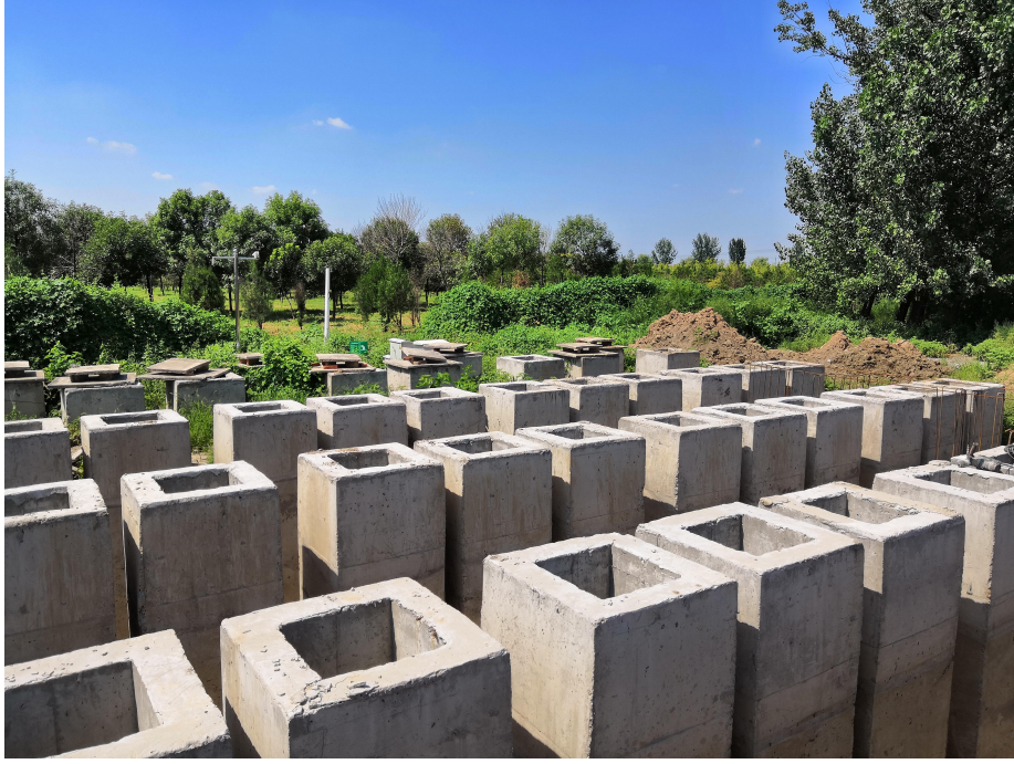
原仇庄污水处理站（已停运）
