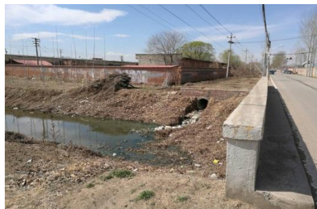
村内明渠现状
