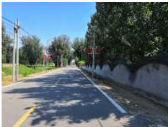
厂区北侧现状道路
