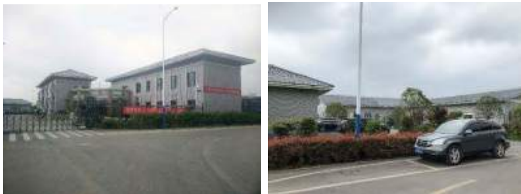
办公生活区（职工食堂、办公楼） 辅助功能区（变电站、污水处理站）
