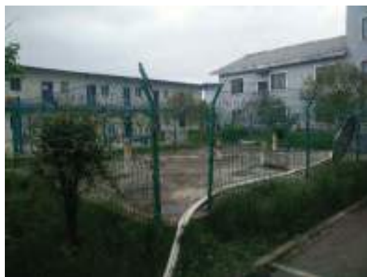
生活水池、消防水池（地下）
