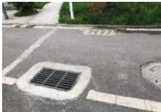
航站区雨水收集
