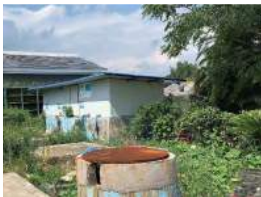
好氧池、初沉池、终沉池
