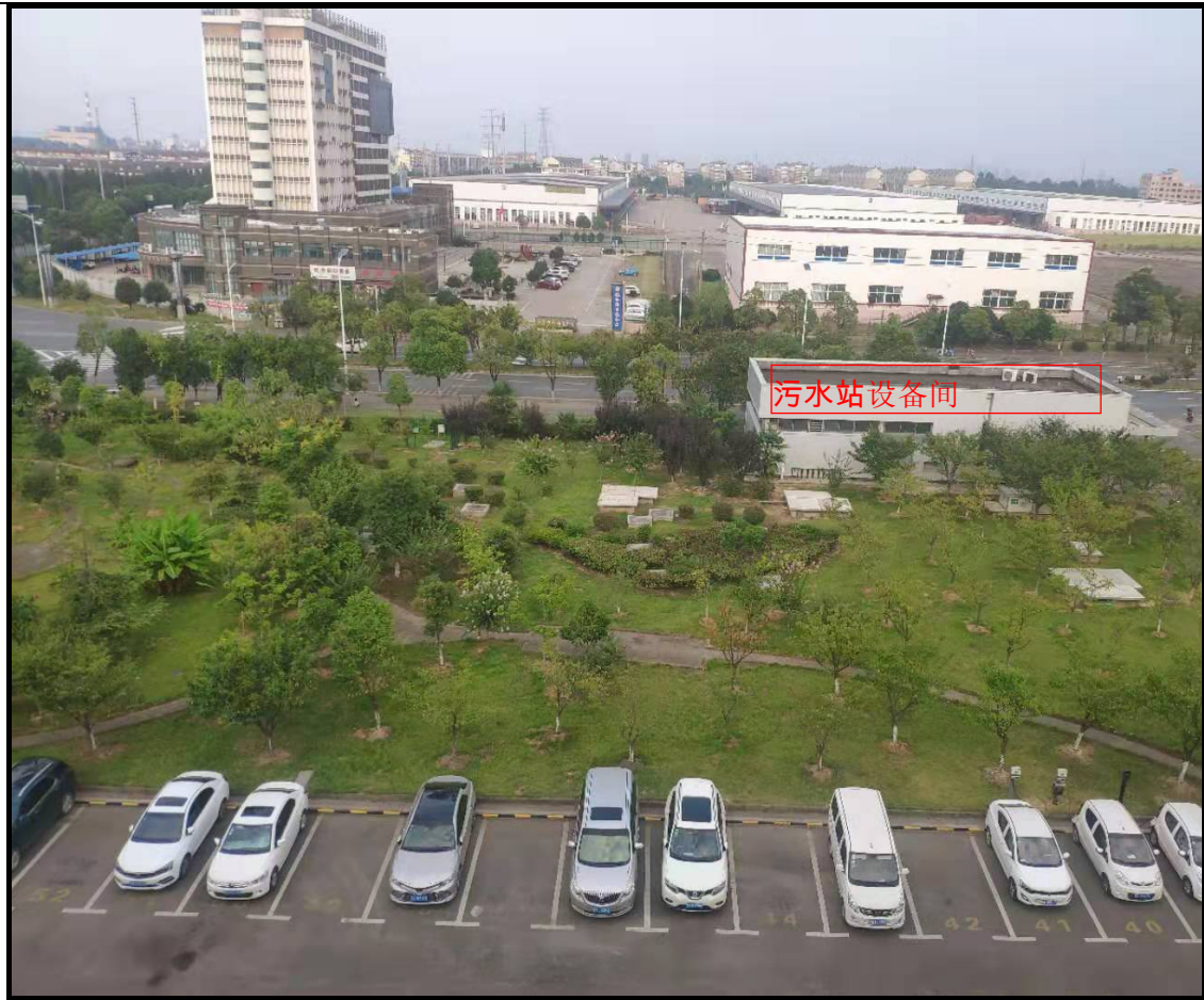
图 6 地埋式污水生化处理区
