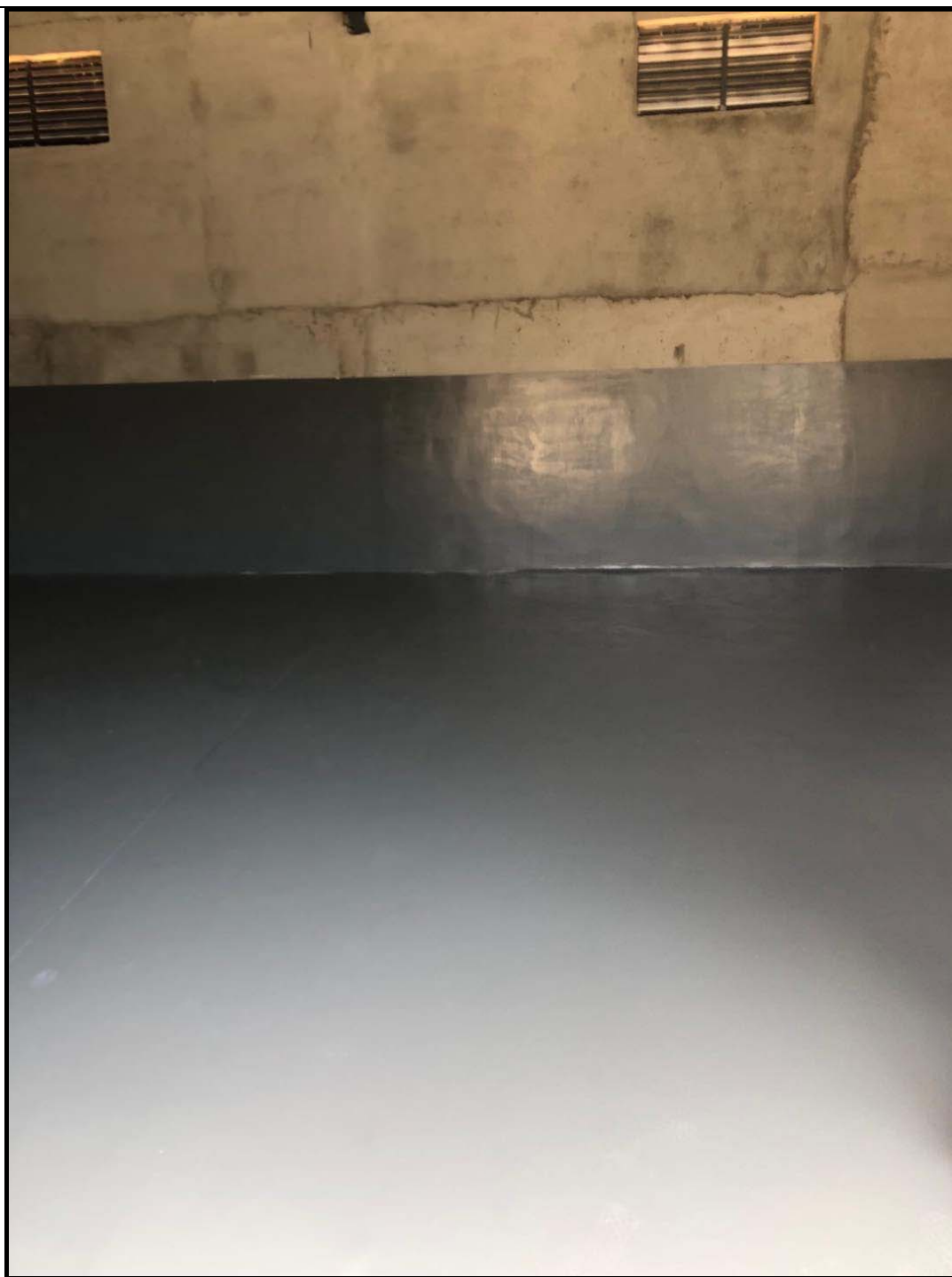
图 10 危废暂存间内部地面防渗及防渗裙角
