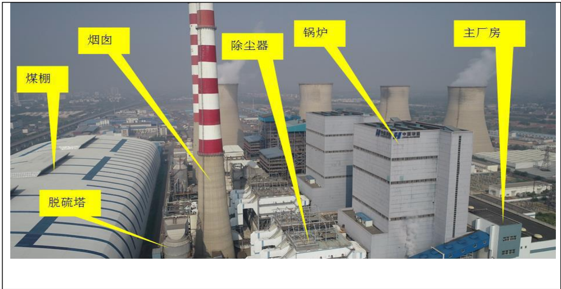
图 3.1-4 机组设备示意图
