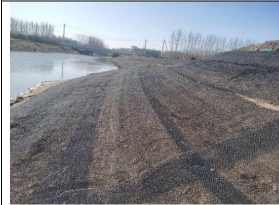
三维水土保持毯铺设
