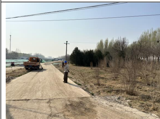
临时道路硬化处置
