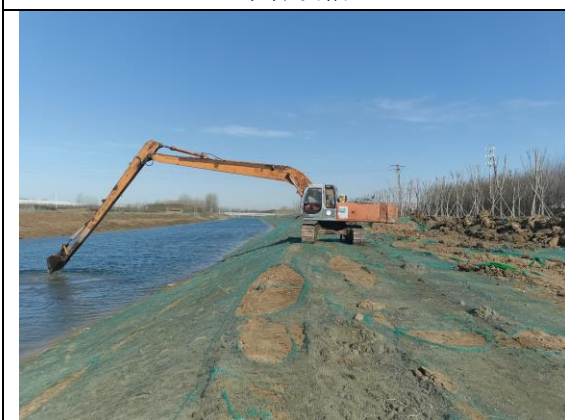
河道土方开挖
