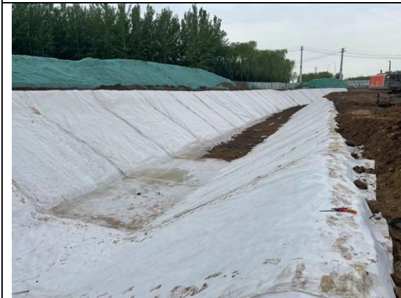
明渠导流铺设土工布
