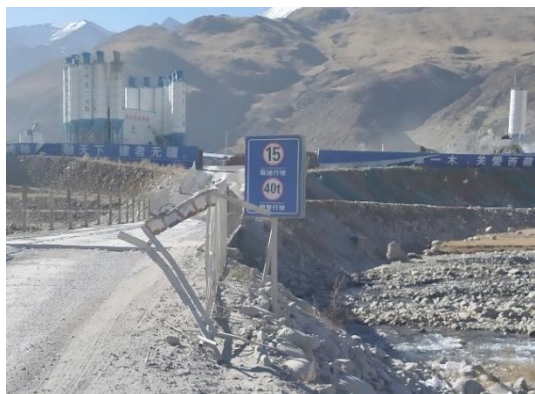
施工限速标志
