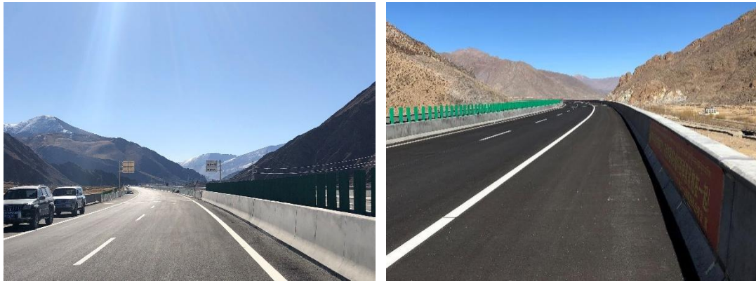
堆龙曲特大桥防撞护栏及限速标志 伴河路段防撞护栏
