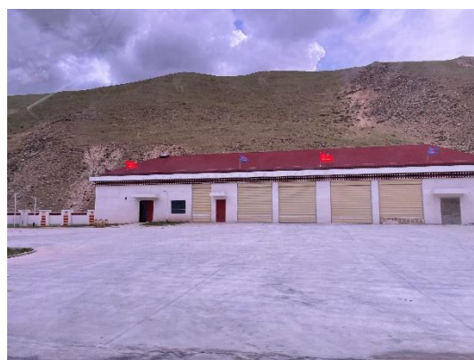
羊八井隧道消防救援站
