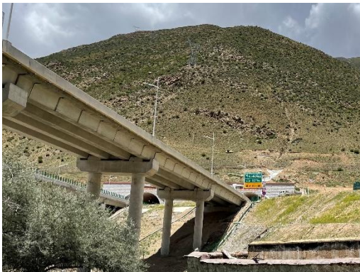
隧道口植被恢复情况
