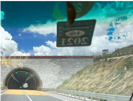
平硐口植被恢复情况
