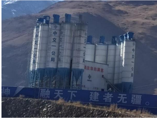
拌合站及除尘装置
