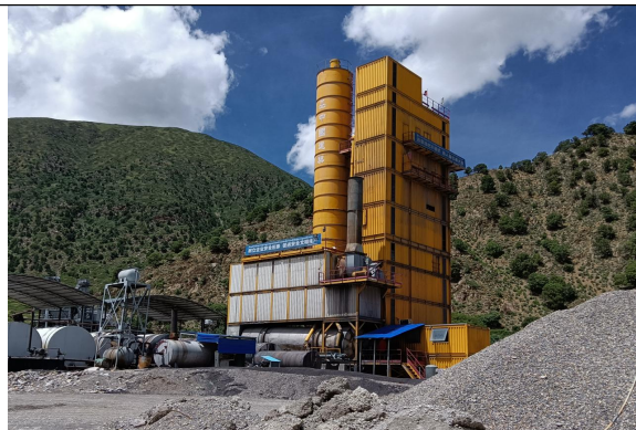
施工设备配置环保设施
