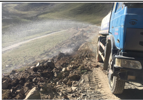
道路施工洒水降尘及植被维护
