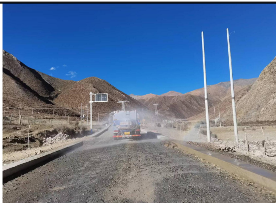
道路施工洒水降尘
