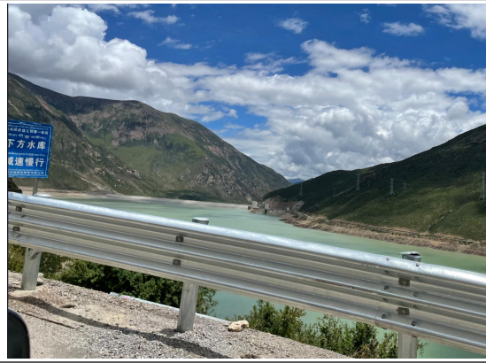
旁多水库防撞护栏及风险警示牌
