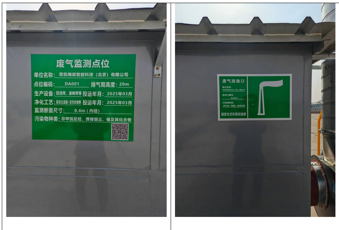
图 4.1-6 废气排气筒规范化情况
