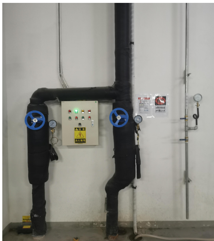
图 4.1-8 换热站、冷冻站废水排放口
