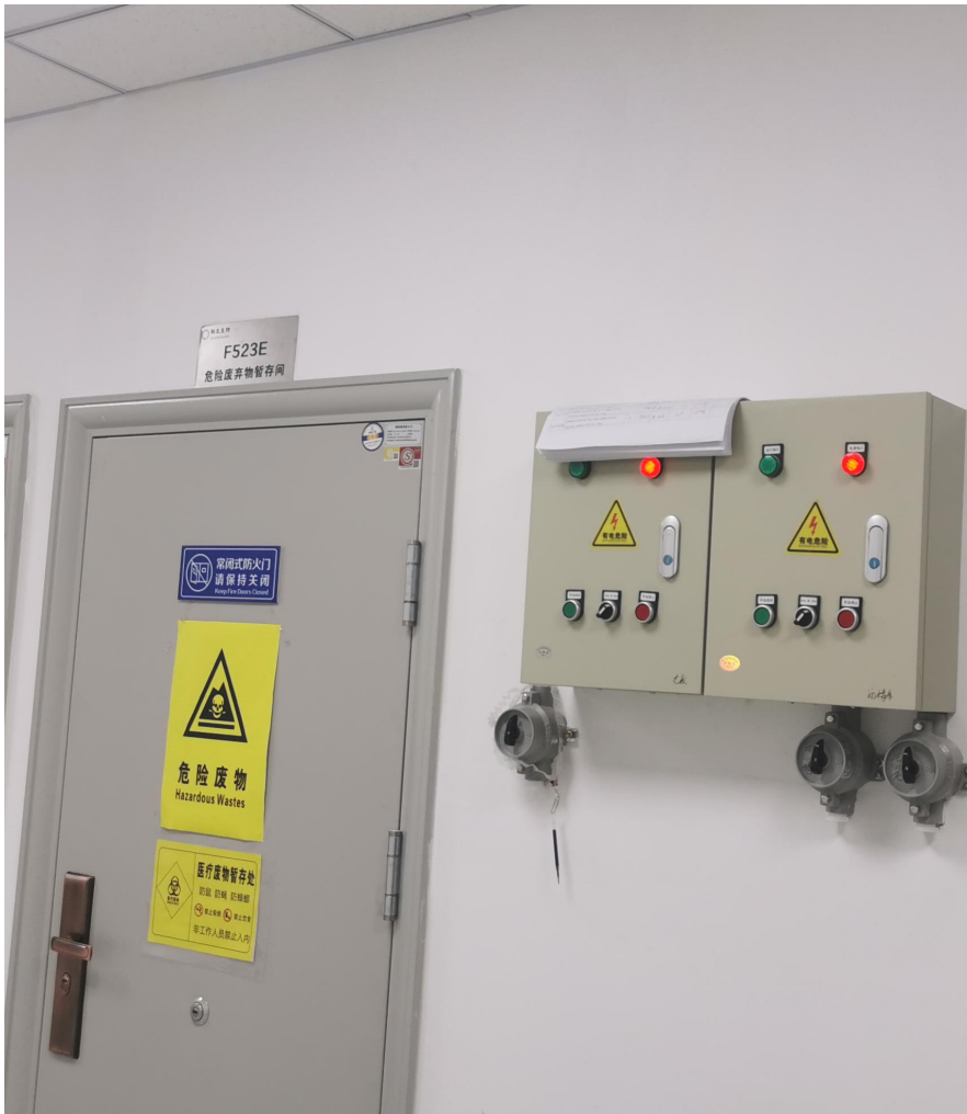
图 4.1-11 危废暂存间照片
