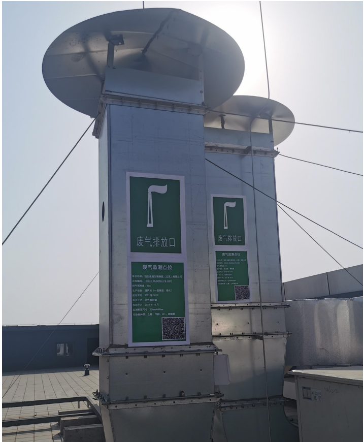
图 4.1-3 核型分析废气和理化实验废气排放口、样品准备间废气排放口
