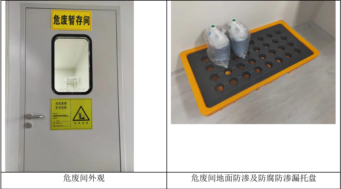
图 4.1-5 危废收集及暂存间建设情况
