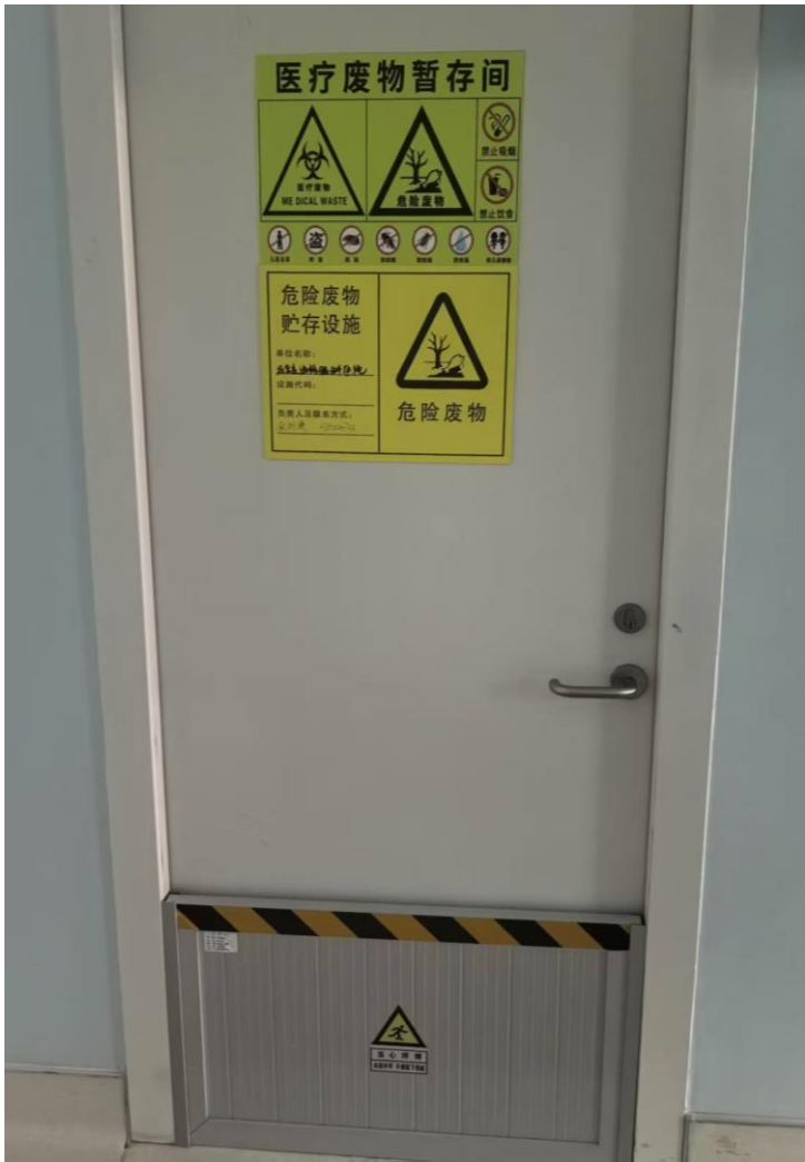
图 4.1-3 危险废物暂存规范化情况
