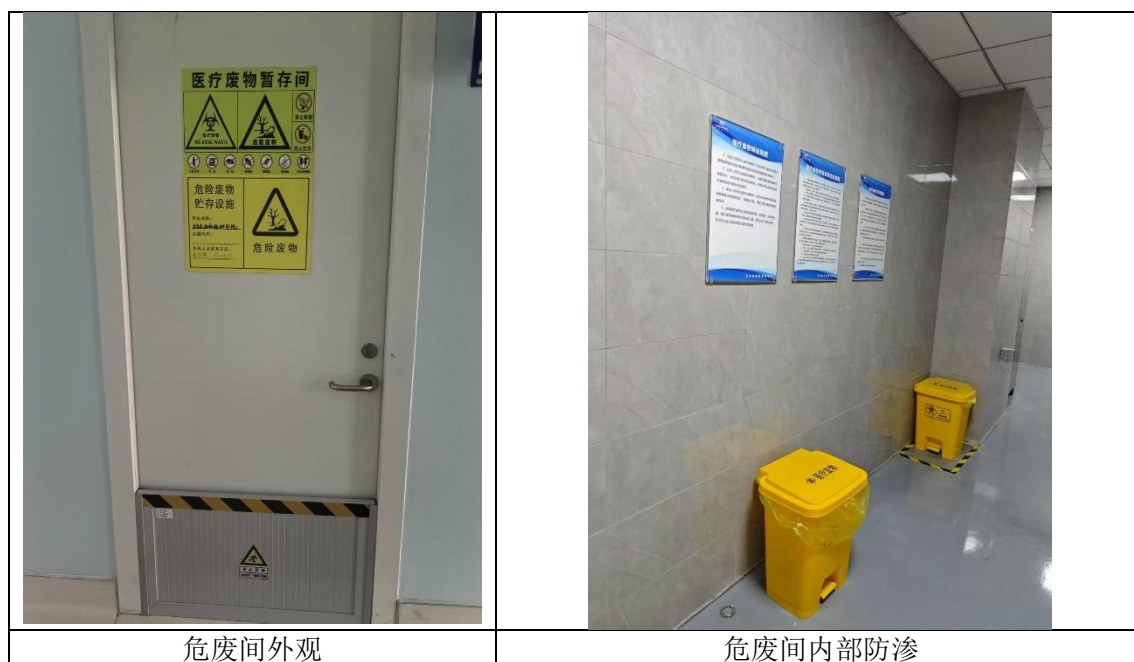
图 4.1-2 危废暂存间建设情况
