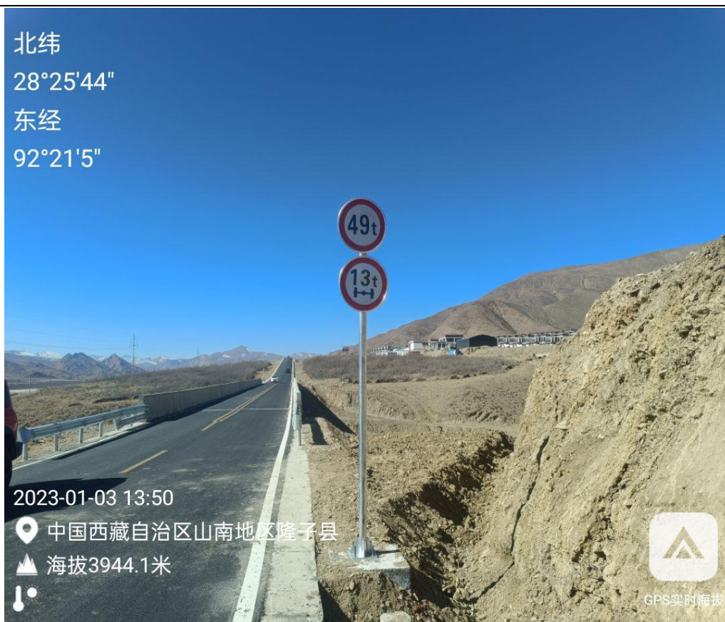
图 4-3 隆子机场 1 号中桥及防撞护栏图片
