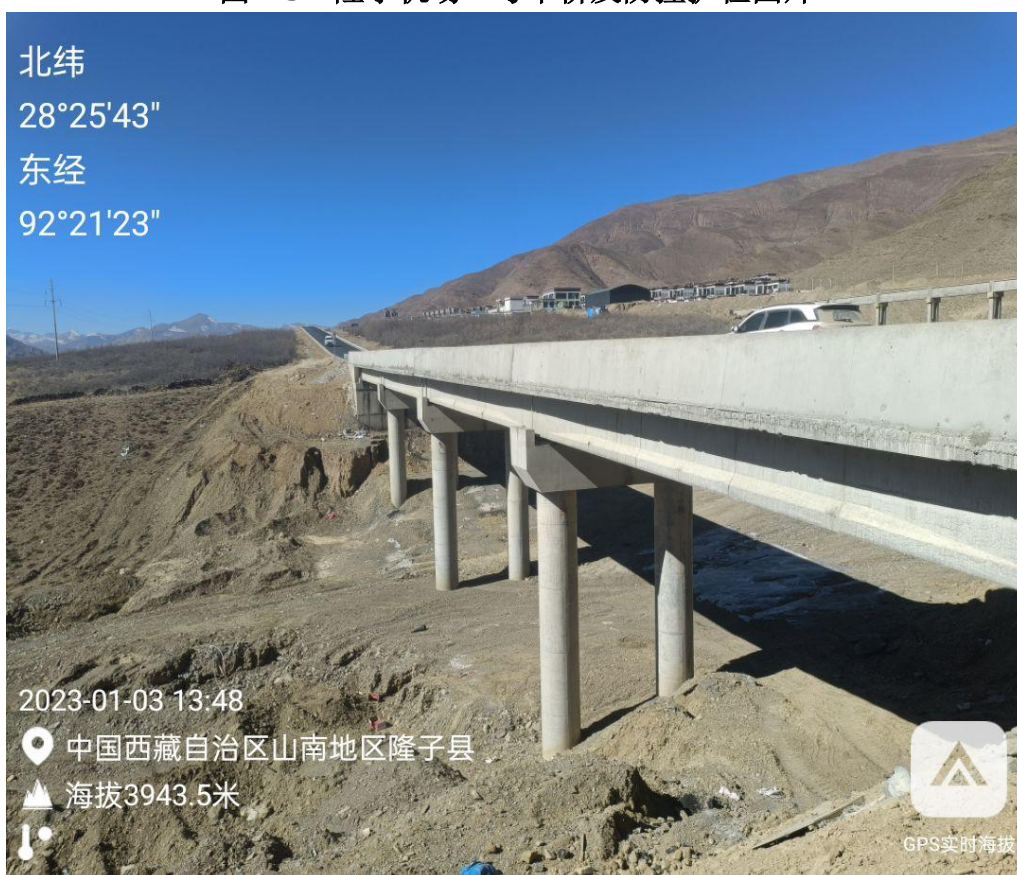
图 4-4 隆子机场 2 号中桥及防撞护栏图片
